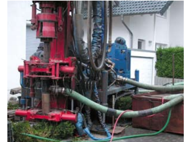
Bohrgerät im Einsatz
