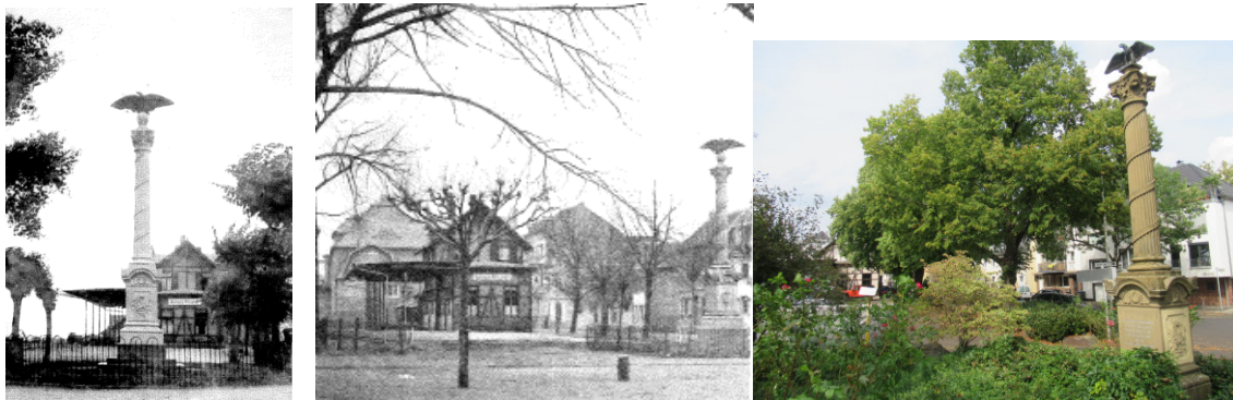
16. + 17. Empfangsgebäude Brölbahnhof, Kriegerdenkmal um 1906 (Schneider 2000, S.32) und vor 1914 (Höroldt 1989, S.332)
