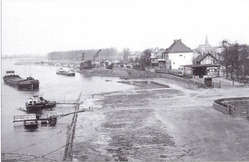
31: Bahnhof, Verwaltungsbau, im Hintergrund: Sturzgerüst für die Basaltentladung
