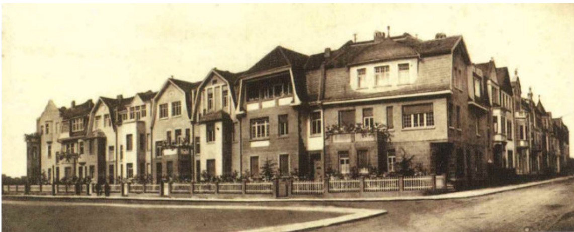
11: Rathaus-/ Combahnstraße, um 1920; Blick nach Nordosten
