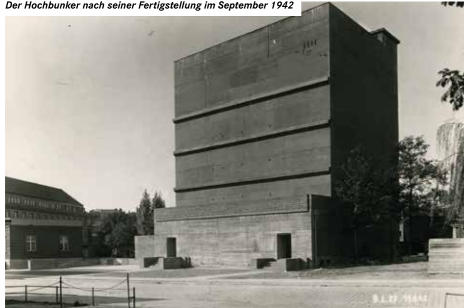
Der Hochbunker nach seiner Fertigstellung im September 1942
