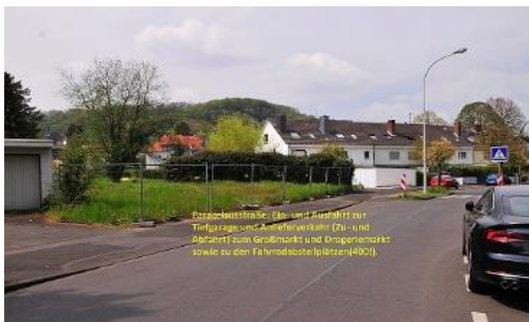
Abbildung 6 Bild Nr.10 Paracelsusstraße 120
