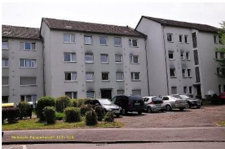
Abbildung 7 Bild Nr. 11 Paracelsusstraße 112-118
