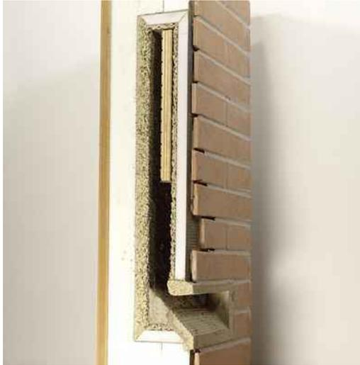
*Abb. 4: In die Fassade integriertes Fledermausquartier. Von außen bleibt nur der schmale Einflug sichtbar. Bei Einsatz in unbeheizten Bereichen (z.B. bei Staffelgeschossen in umlaufenden Brüstungen) stellt die verminderte Wärmedämmung keinen Nachteil dar.*
