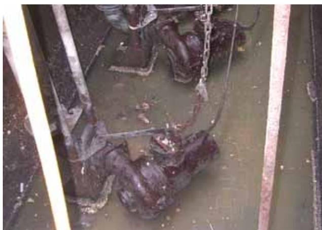
*Neue Tauchmotorpumpen, mit PEHD Rohrmaterial in der Bauphase*
