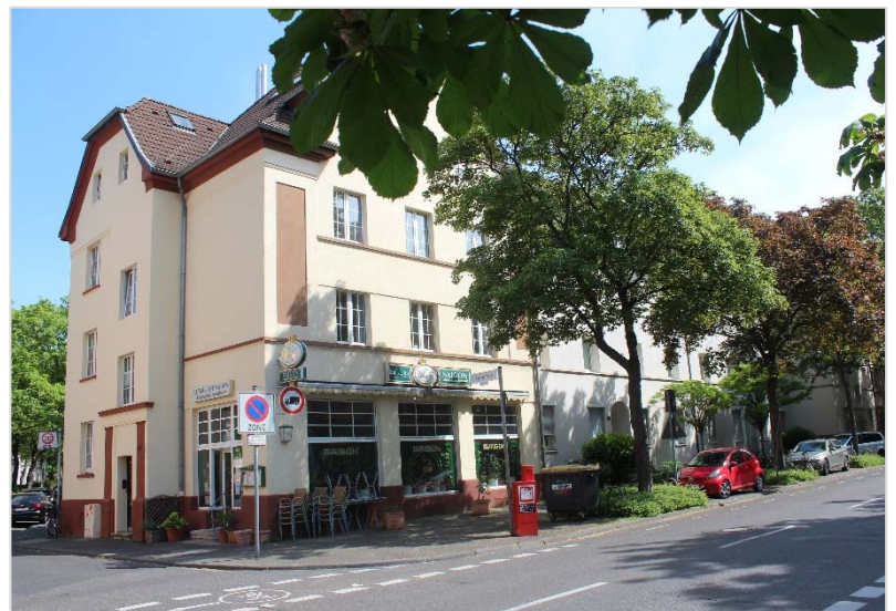
Abbildung 41 und 42: Ellerstraße 1-7 und Ellerstraße 1, 2018
